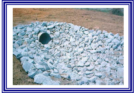
Riprap Outlet Protection
