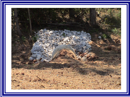
Riprap Outlet Protection
