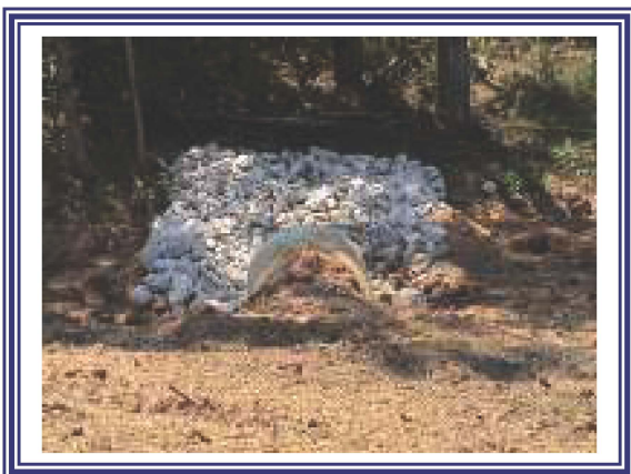
Riprap Outlet Protection
