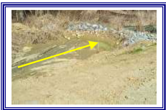
Rock Sediment Dike
