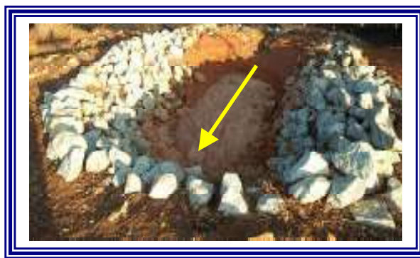
Rock Sediment Dike
